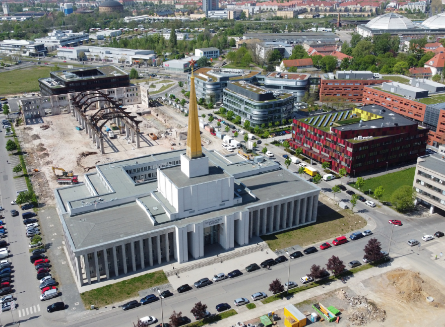
Blick auf die Baustelle der Halle 12 (ehemals Sowjetischer Pavillon) Foto: LGH, Leipziger Gewerbehof GmbH & Co. KG
